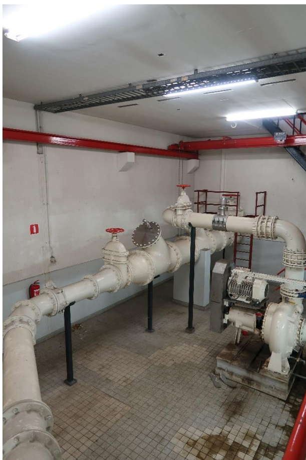
Afbeelding 17: Zicht op droge kelder, meest westelijke pomp, kraanbaan en uitgaande persleiding aan westzijde van het gebouw. Van de meest oostelijke pomp is slechts de afvoerende leiding te zien (links op de foto).
