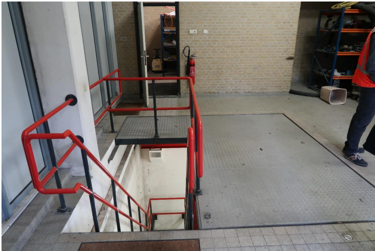
Afbeelding 7: Zicht op trap naar droge kelder. Traanplaat luik valt te verwijderen.
