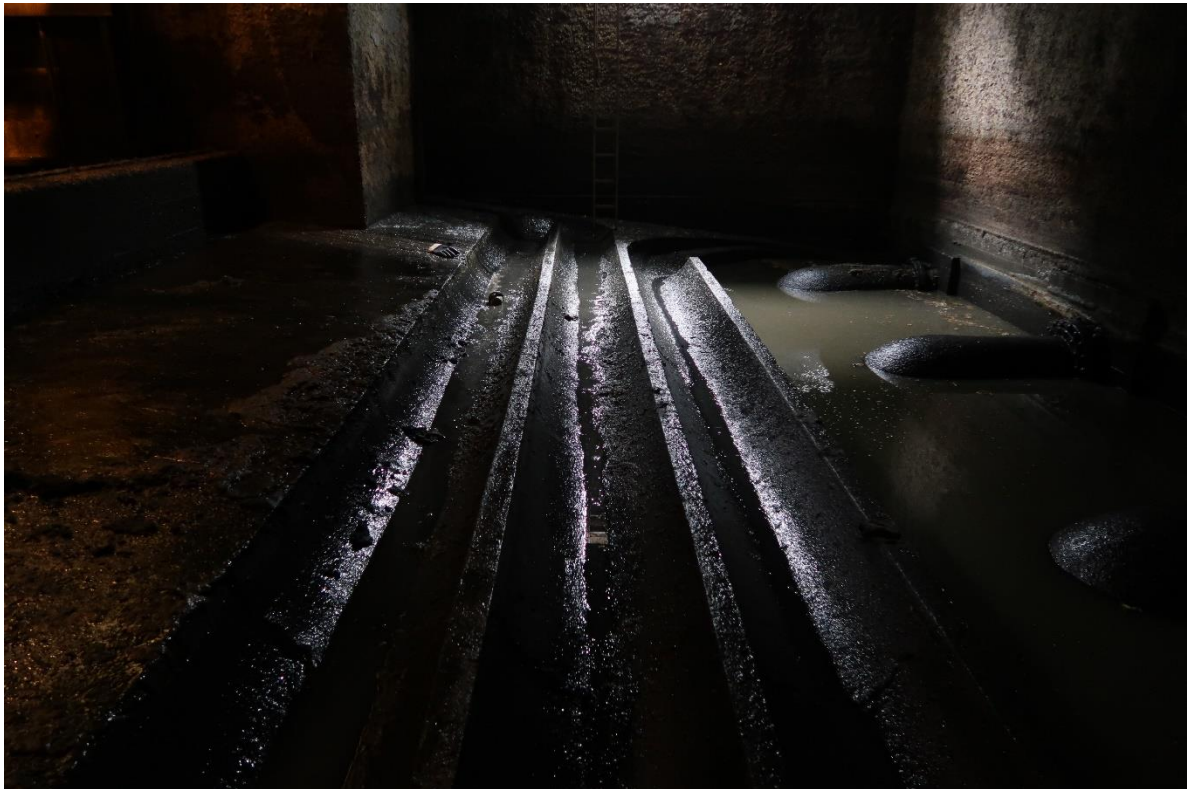
Afbeelding 14: Zicht op oostelijke kelderwand met slingergoten en zuigmonden
