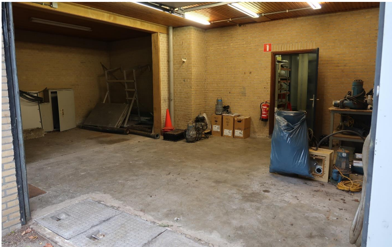
Afbeelding 4: Zicht op ruimte "Plantsoenendienst" (zie figuur 1) aan oostzijde gebouw. Zichtbaar zijn 3 toegangsluiken tot vuilwaterkelder met slingeroot
