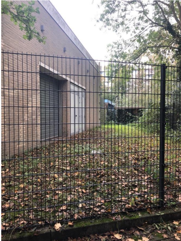
Afbeelding 1: Zicht op zuidelijke gevel gebouw met toegang tot bedieningsruimte (rolluik links), meterkast (grijze deur midden) en ruimte "Veegpost reiniging" (grijze deur rechts)
