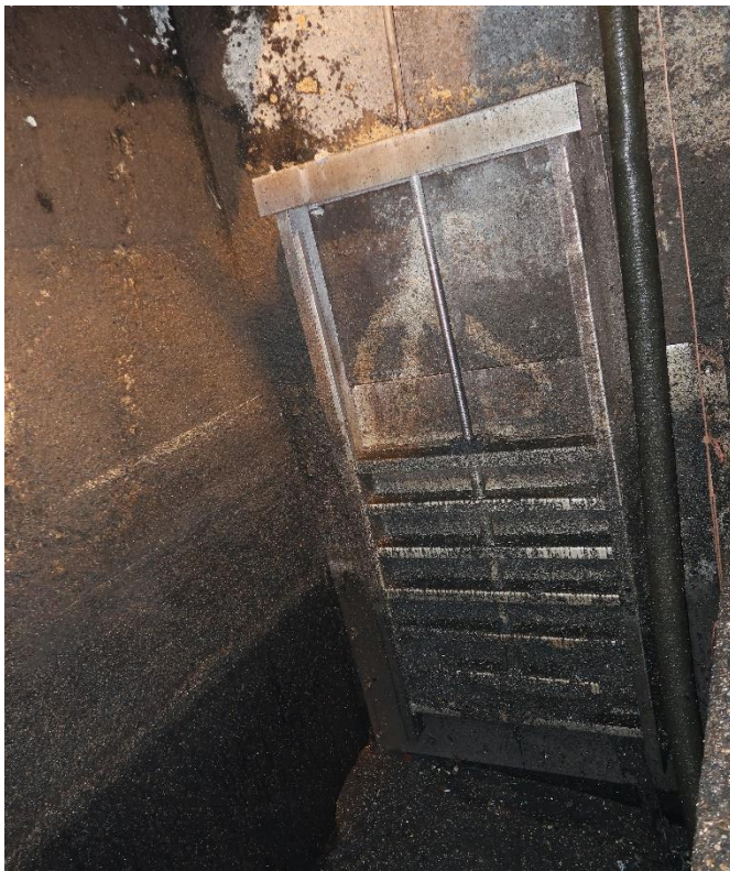
Afbeelding 11: Zicht op afsluiter tussen zandvang en ontvangkelder. Aan de rechterzijde van het luik is de tijdelijke zuigleiding zichtbaar t.b.v. het legen van de zandvang.
