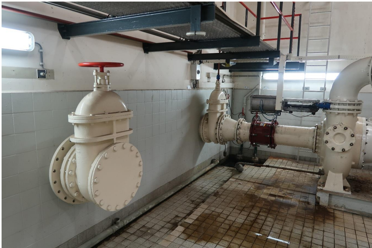
Afbeelding 18: Zicht op de meest westelijke pomp en een afgesloten muurdoorvoer, behorende bij de middelsde zuigmond in de natte kelder. In de hoek van de ruimte zijn de twee lenspompen te zien.
