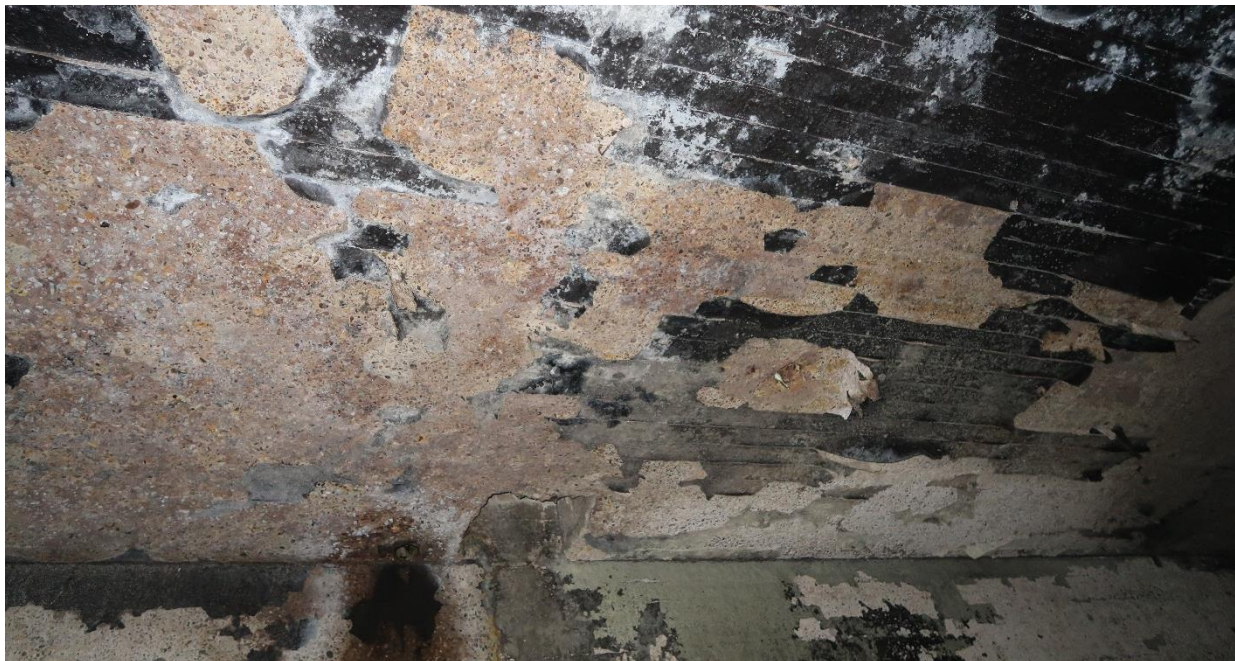
Afbeelding 16: Zicht op plafond natte kelder, zichtbaar is natte plek op de muur t.g.v. een lozingsleiding.
