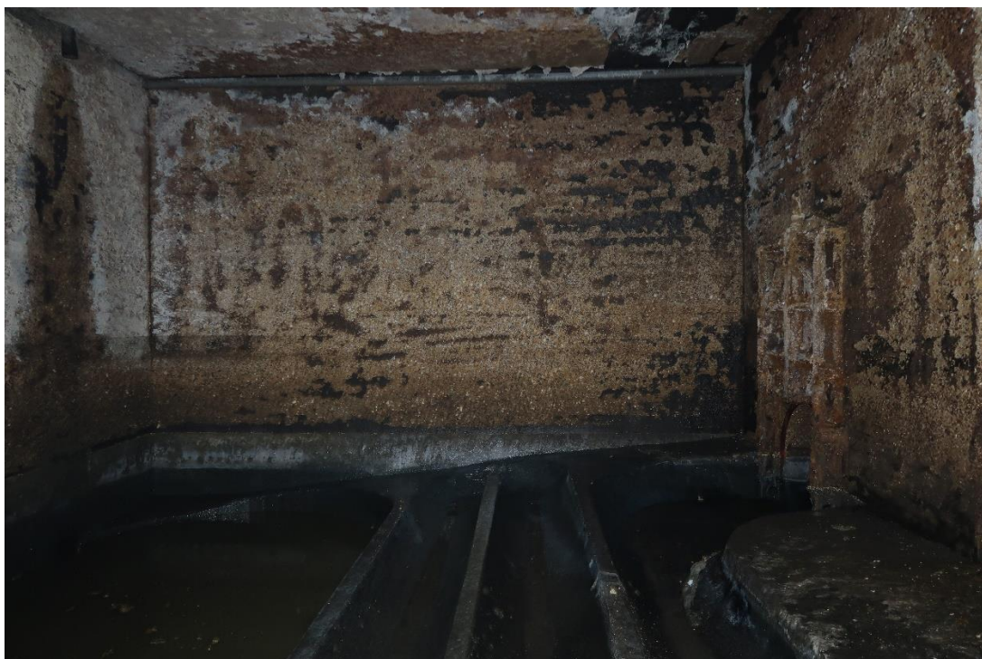
Afbeelding 13: Zicht op slingergoten en westelijke keldermuur. Aan de rechteronderzijde is de afsluiter richting het snijrooster zichtbaar.
