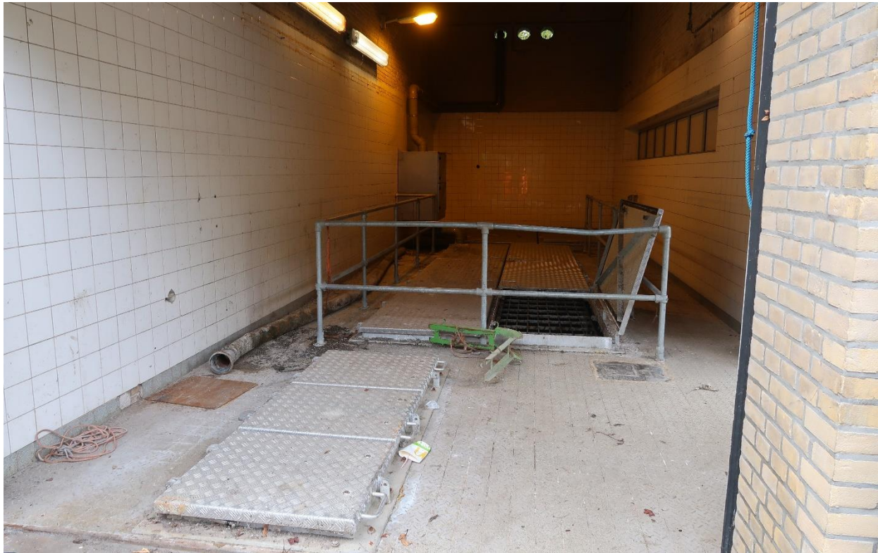
Afbeelding 3: Zicht op luiken ontvangstkoker (voorgrond), luiken zandvang/snijrooster (achtergrond) en bestaande geurfilterinstallatie (grijze kast aan linkerkant van ruimte)
