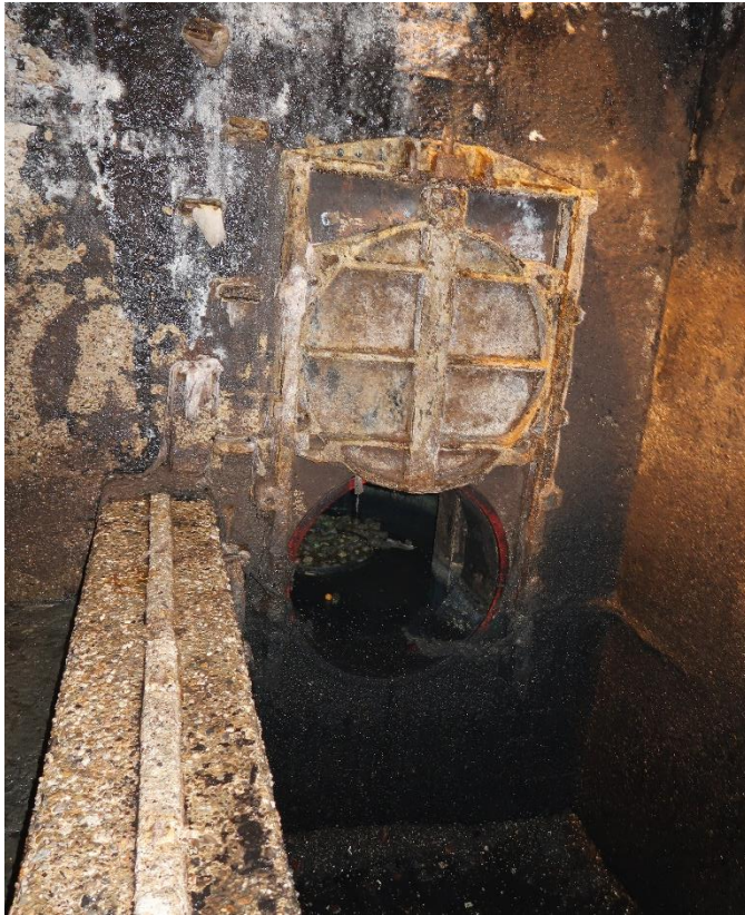
Afbeelding 10: Zicht op afsluiter tussen zandvang en snijrooster & muur tussen zandvang en gotenkelder
